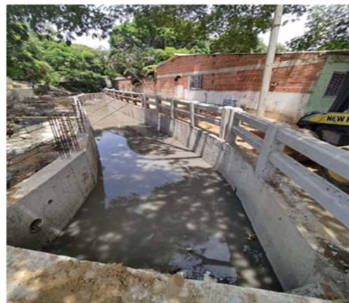
Construcción de losa de fondo, muros y barandas en el Arroyo Villegas el cual tributa sus aguas hacia el Arroyo El Salao.
